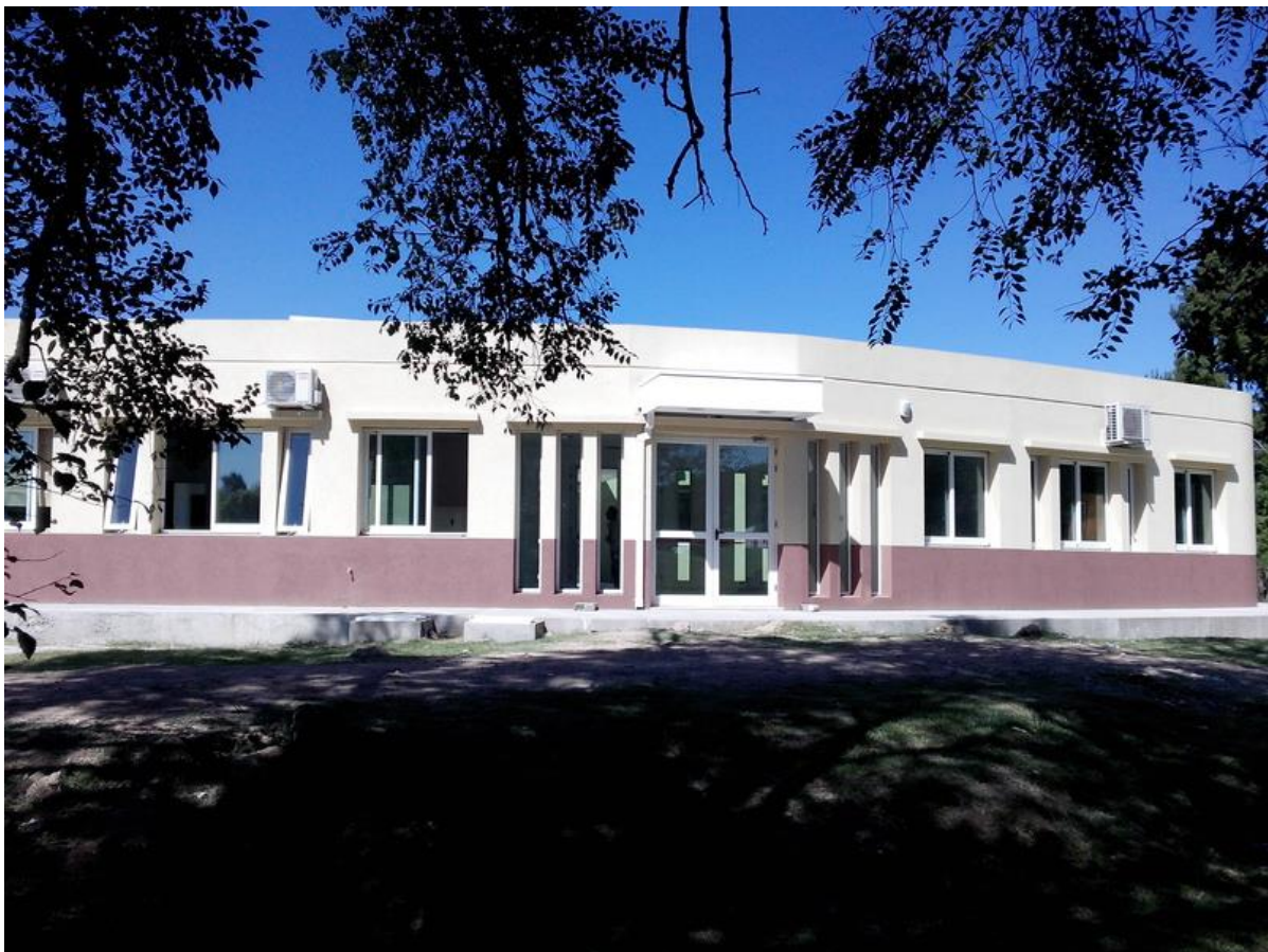
Figura 1. Instituto de Tecnología Nuclear Dan Beninson. Edificio n° 1, CAE
