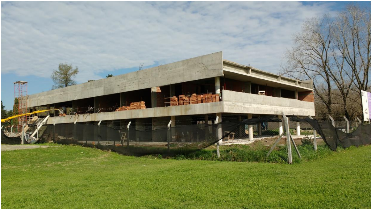
Figura 2. Instituto de Tecnología Nuclear Dan Beninson. Edificio n° 2, CAE
