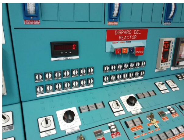
Fig. 7 – POSICIÓN DE LAS BARRAS DE SEGURIDAD
